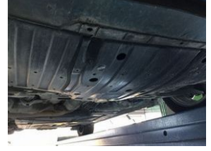
Motor Alt muhafaza > hasarlı
