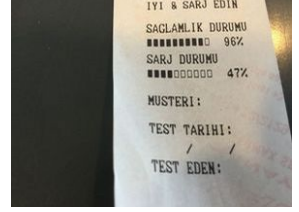
Elektrik donanımı/Pano Akü > Test Sonucu
