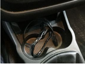
Elektrik donanımı/Pano Kablo demeti > onaysız
