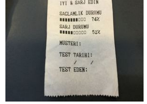
Elektrik donanımı/Pano Akü > Test Sonucu
