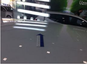
Tavan Tavan > Dolu hasarı
