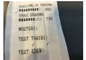
Elektrik donanımı/Pano Akü > Test Sonucu
