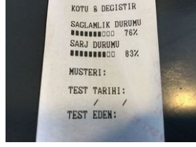
Elektrik donanımı/Pano Akü > Test Sonucu
