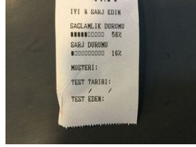
Elektrik donanımı/Pano Akü > Test Sonucu
