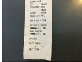
Elektrik donanımı/Pano Akü > Test Sonucu
